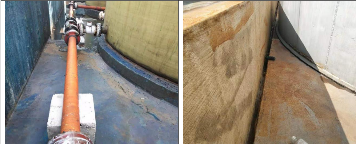
酸碱罐区：盐酸、液碱储罐区地面已做防腐防渗处理，四周设有围堰、导排沟，地面无破损。
