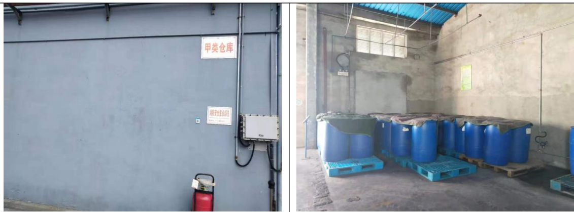
甲类仓库：存放危化品材料，仓库内地面均已硬化，无破损。
